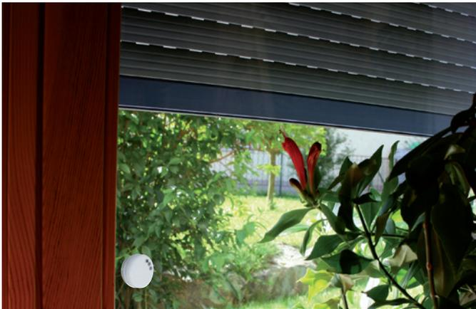
Lichtsensoren für Funkantriebe schließen Ihre Rollläden wenn es dunkel wird. Glasbruchsensoren lassen Ihre Rollläden bei Erschütterung der Scheibe schließen. Sonnensensoren lassen Ihre Rollläden in eine voreingestellte Sonnenschutzposition fahren. Funkantriebe, entsprechende Sensoren und Steuerungen vereinfachen das Leben in besonderem Maße und schützen obendrein noch Ihr Hab und Gut.
