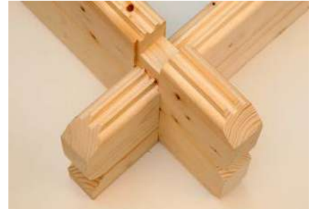
Winddichter Eckversatz
