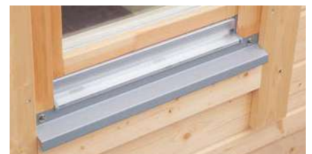
Fenster mit Metall-Fensterbank
