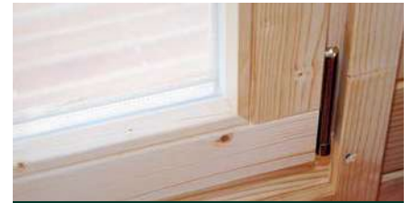
Isolierverglasung ab 34 mm Wandstärke
