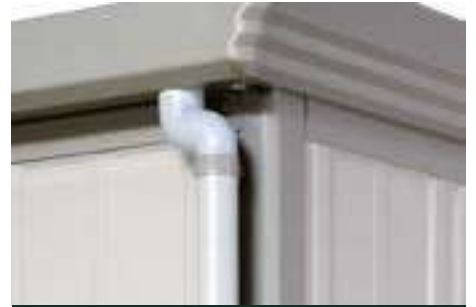
Dachrinne mit Regenfallrohr
