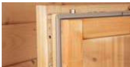
Fenster- und Türdichtung
