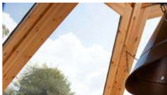
Glasdachelemente im Tausch
