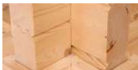
Eckverbindung 70-mm-Bohle
