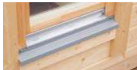
Fenster mit Metall-Fensterbank
