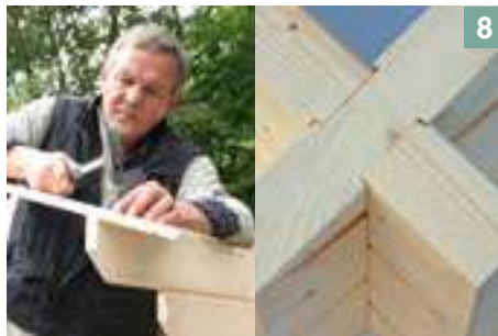
Optimale Auflage der Dachbretter
