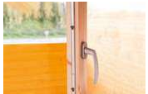
Dreh-/Kipp-Fenster mit 3-fach Verriegelung
