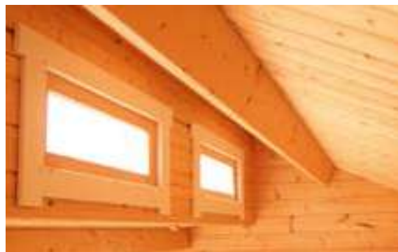
Lina 4031 | Innenansicht Dach und Fenster
