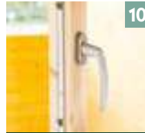
Dreh-/Kipp-Fenster mit 3-fach Verriegelung
