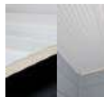
Geschäumte Dachisolierung (42 mm)
