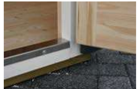
Isolierverglaste Leimholz-Türen mit Metall-Türschwelle
