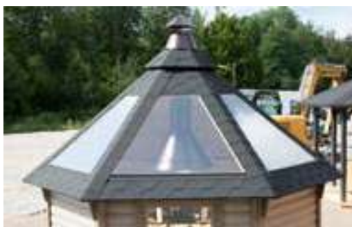
Glasdachelemente im Tausch
