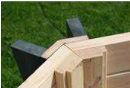
Stabile Auflage für den Dachkranz
